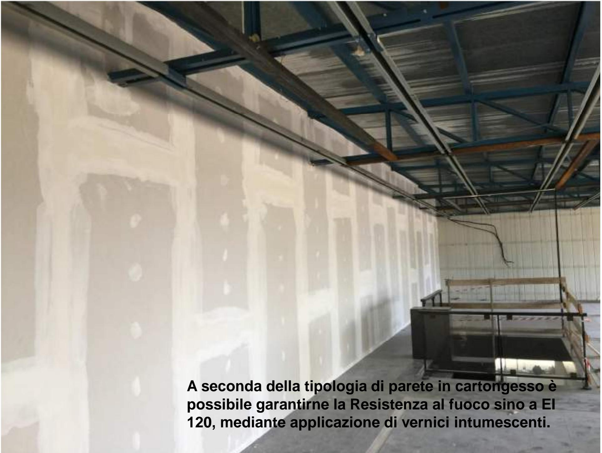
**A seconda della tipologia di parete in cartongesso è possibile garantirne la Resistenza al fuoco sino a EI 120, mediante applicazione di vernici intumescenti.**
