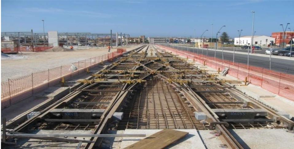
Elevata velocità di realizzazione e posa degli scambi con metodologia di campo per riduzione polveri di cantiere e riduzioni di carreggiata.
