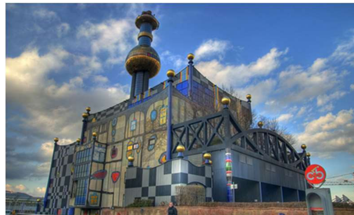
L'impianto tratta 260.000 t , genera annualmente 40.000 MWh di EE e 470.000 MWh di calore e si trova nel centro di Vienna
