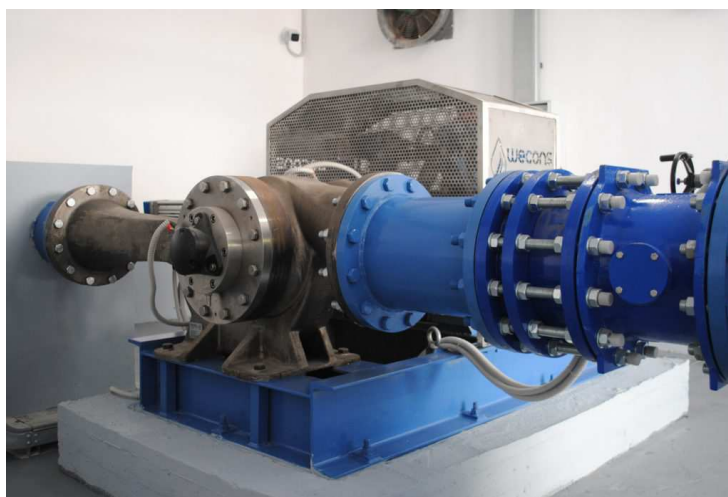
Turbina PR5 in linea con la condotta di arrivo del nodo di San Giovannello (TP)
