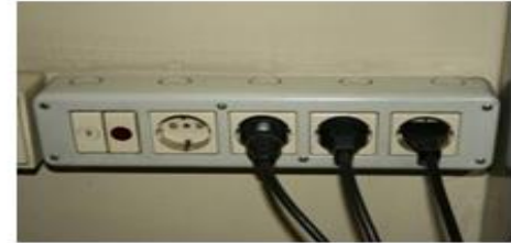
PRESE A SPINA (Le spine e i cavi di alimentazione degli apparecchi utilizzatori non fanno parte dell'impianto )
