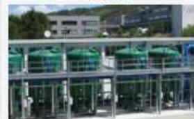
I microinquinanti organici, presenti nelle acque di falda a causa di attività antropiche, possono essere rimossi principalmente tramite adsorbimento su carboni attivi. Culligan vanta una grande esperienza in merito, garantendo un'elevata efficienza di rimozione e sicurezza per il consumatore.
