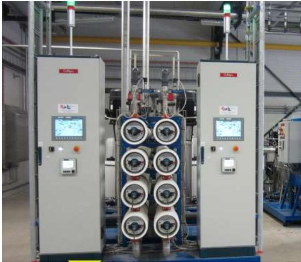
Fonterra è una grande latteria sita a Berkelland, Olanda. La necessità di avere acqua osmotizzata per alimentare le caldaie a vapore, avendo a disposizione la sola acqua di acquedotto (con costo di circa 5 €/m<sup>3</sup>), ha richiesto di minimizzare lo scarico dal rigetto dell'osmosi inversa. Abbiamo per questo studiato una soluzione che permettesse di osmotizzare nuovamente il rigetto delle osmosi primarie, aumentando il rapporto di recupero complessivo al 93%.
