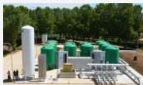
I sistemi di rimozione arsenico e potabilizzazione applicati da Culligan vengono adattati alle specifiche esigenze acquedottistiche, permettendo di abbattere i costi gestionali legati al trattamento acque. Gli impianti di dearsenificazione Culligan possono servire dal piccolissimo acquedotto alla grande metropoli.
