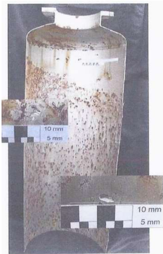
Superficie interna di un serbatoio con corrosione puntiforme diffusa
