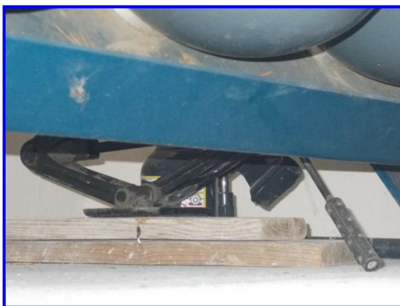
Particolare del posizionamento del crick all'estremità destra in basso del pacco bombole ed in posizione più vicina alla parete retrostante che al fronte del pacco bombole
