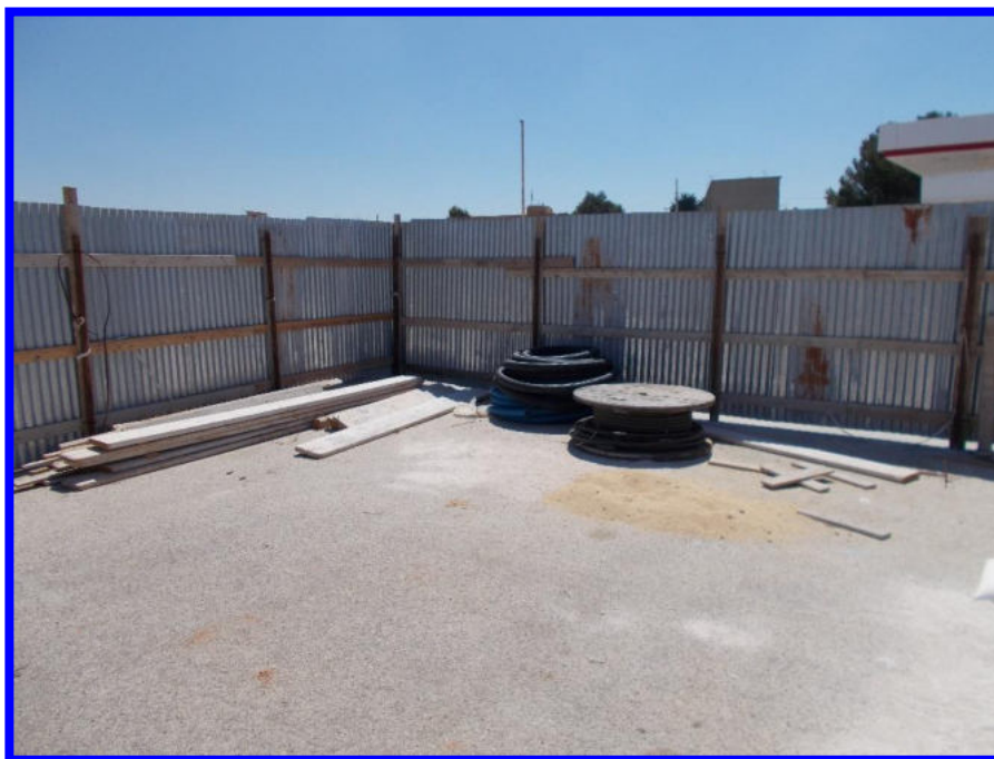
Continuazione recinzione cantiere lato sinistro
