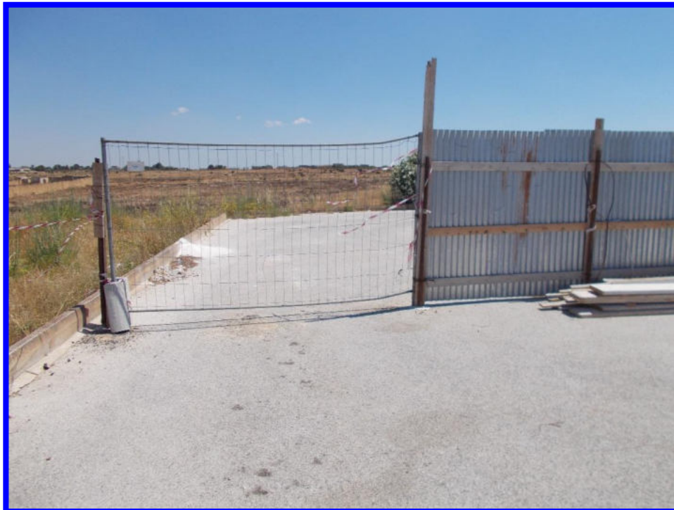
Recinzione cantiere lato sinistro
