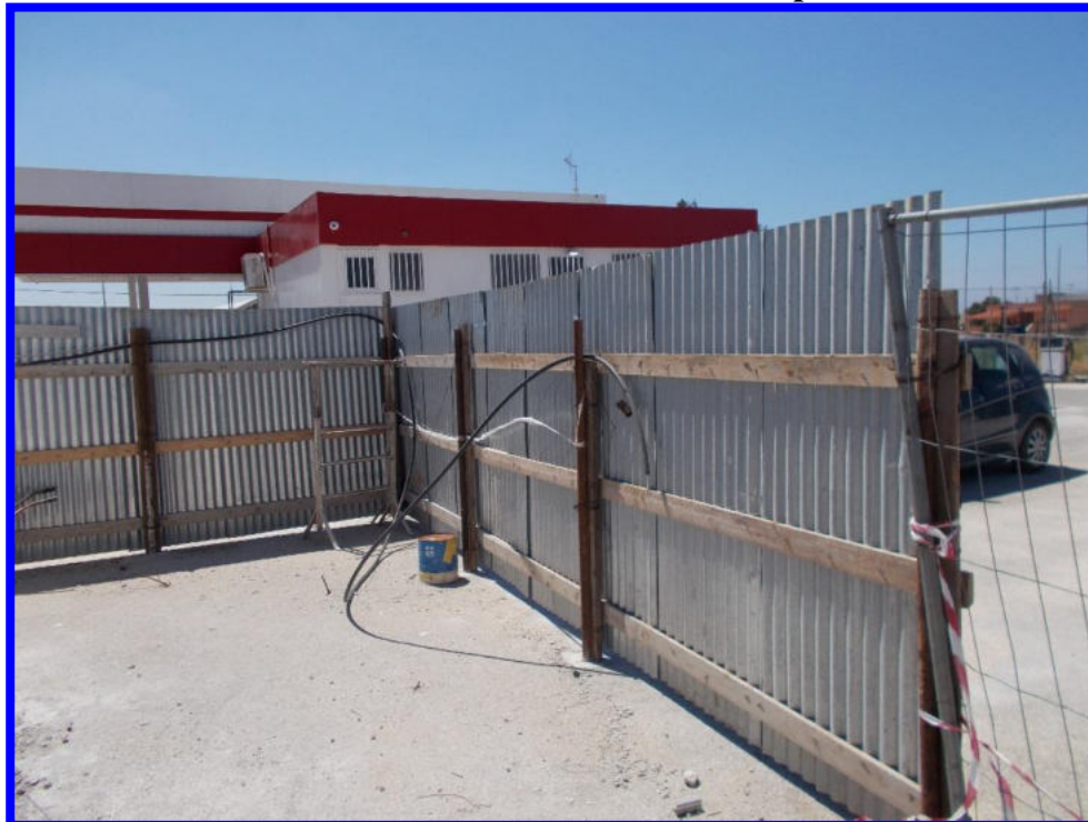
Recinzione lato destro del cantiere di fronte alla porta su indicata
