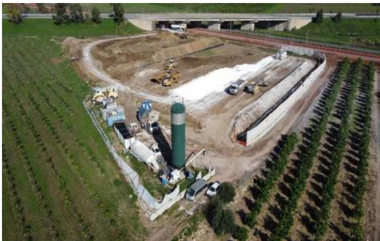
Area di stabilizzazione DT01-L1
