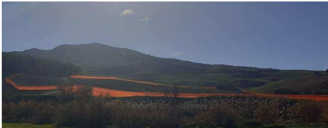
GI01 – IMBOCCO MONTESTRETTO LATO PA
