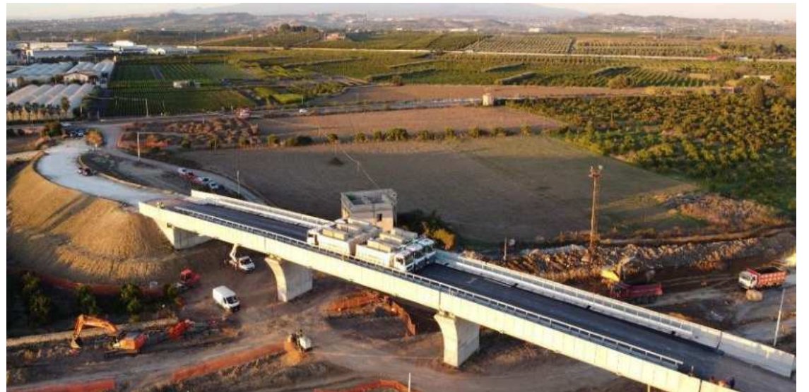
IV05 Cavalcaferrovia al km 17324 strada statale SS 192, costituito da 4 campate aventi luce 30.00 m
