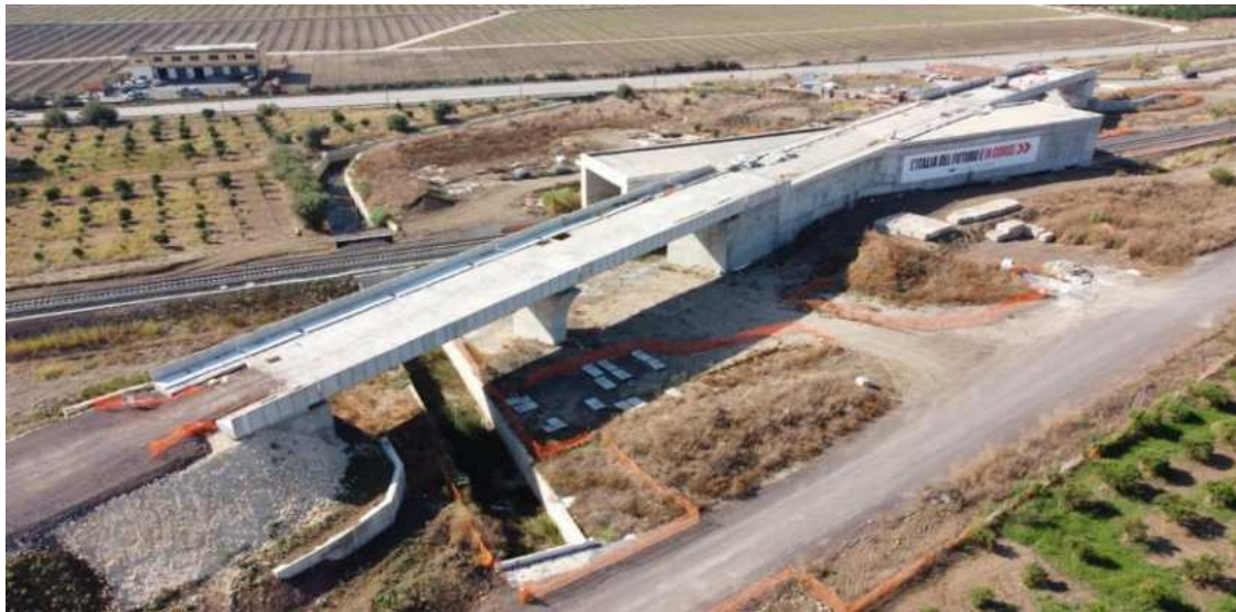
GA 01 - Galleria artificiale di lunghezza di 92,75 m
