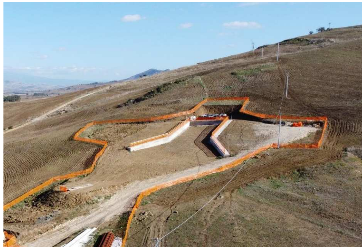
GI01 IMBOCCO GALLERIA LIBERTINIA LATO PA
