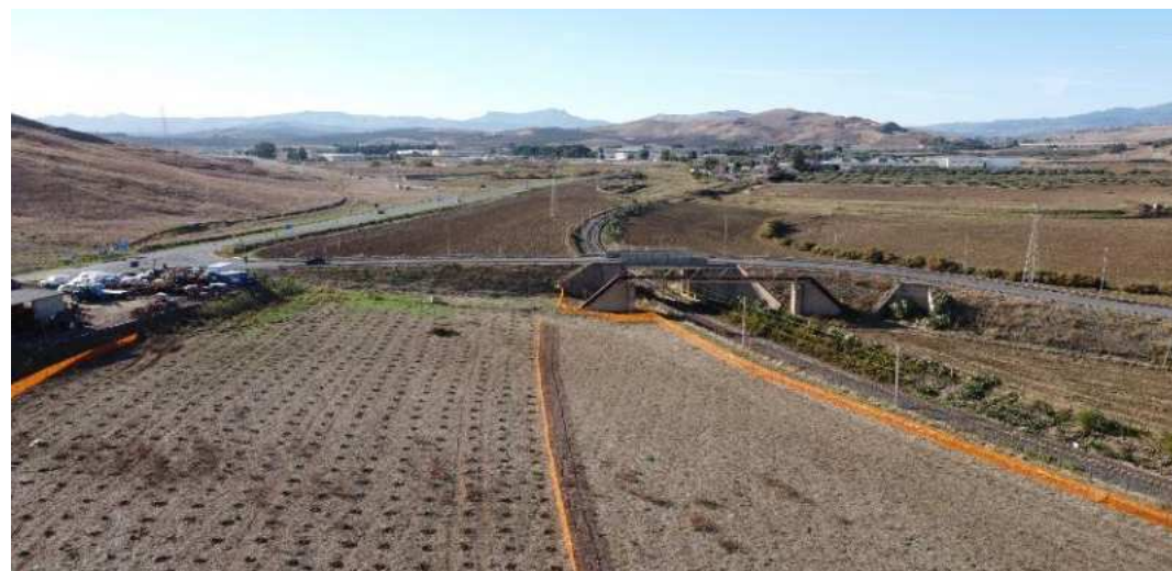
TR05 - Cavalcaferrovia dal km 5+700 al km 5+939
