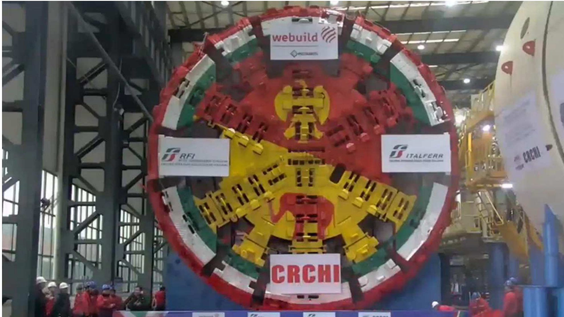
TBM1 che verrà utilizzata per scavare la galleria Sicani
