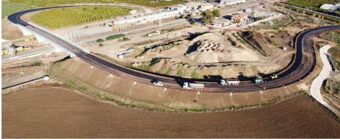
IV02 Cavalcaferrovia al km 11+331 strada provinciale SP 102 costituito da 3 campate aventi luce 30.00 m
