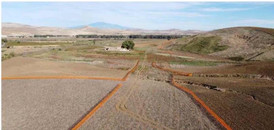
VI02 – Viadotto ferroviario Vallone della Rosa
