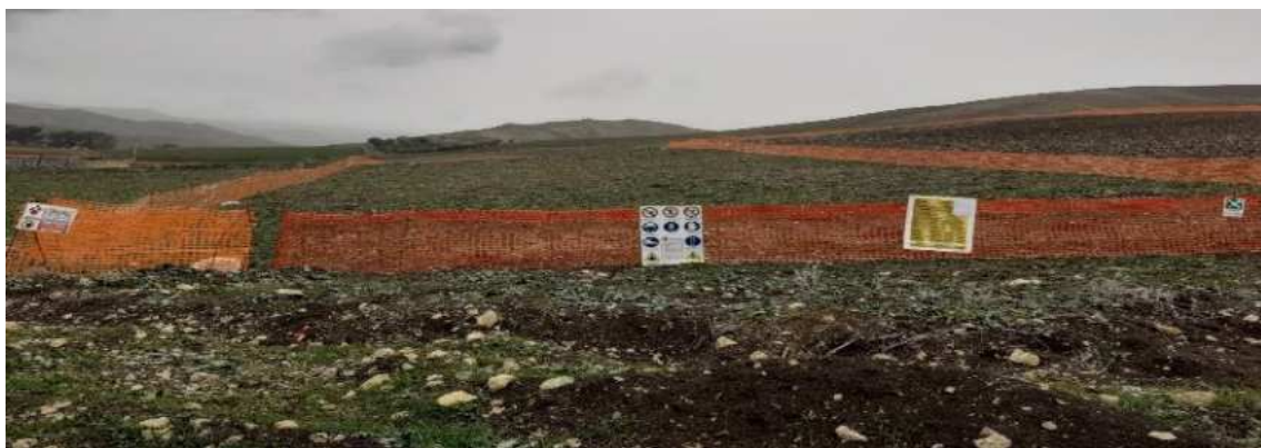
GI03 – Imbocco Nuova Marianopoli Lato Palermo
