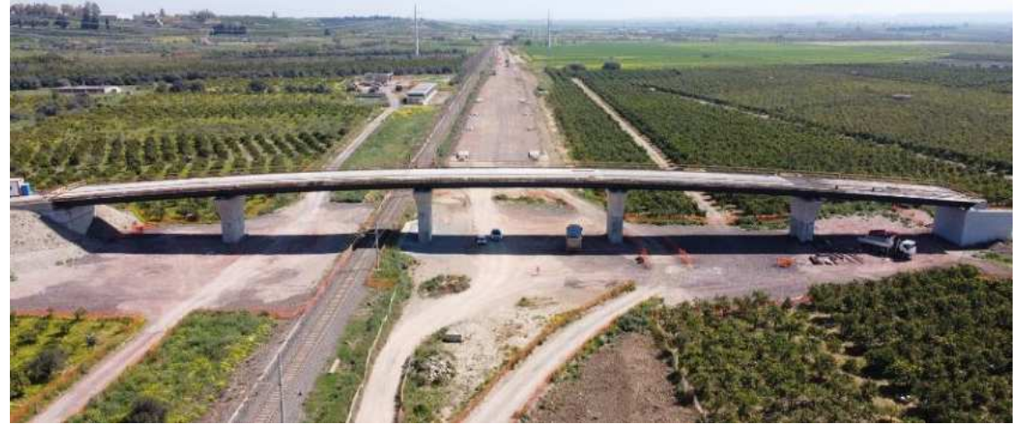
IV04 Cavalcaferrovia al km 27+268 costituito da 5 campate aventi luce 30.00 m
