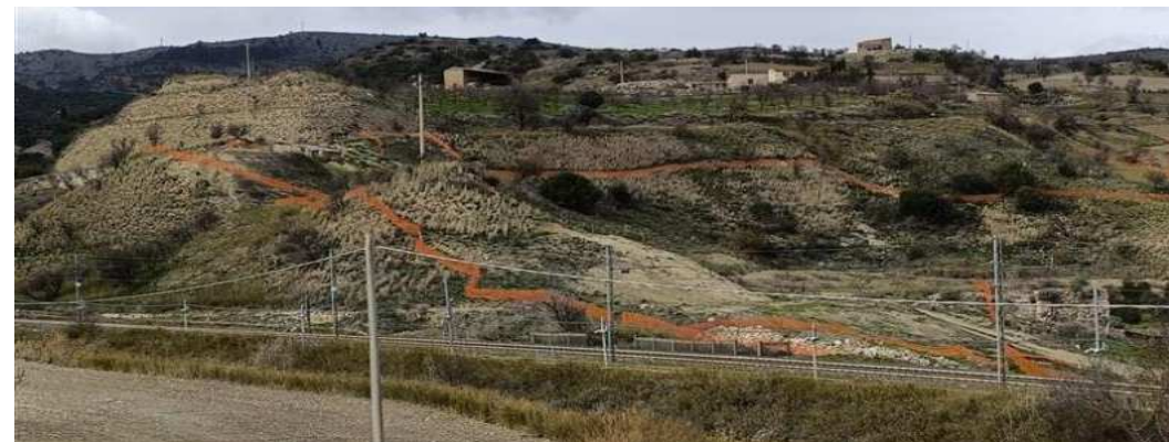
GI04 – Imbocco Nuova Marianopoli Lato Catania
