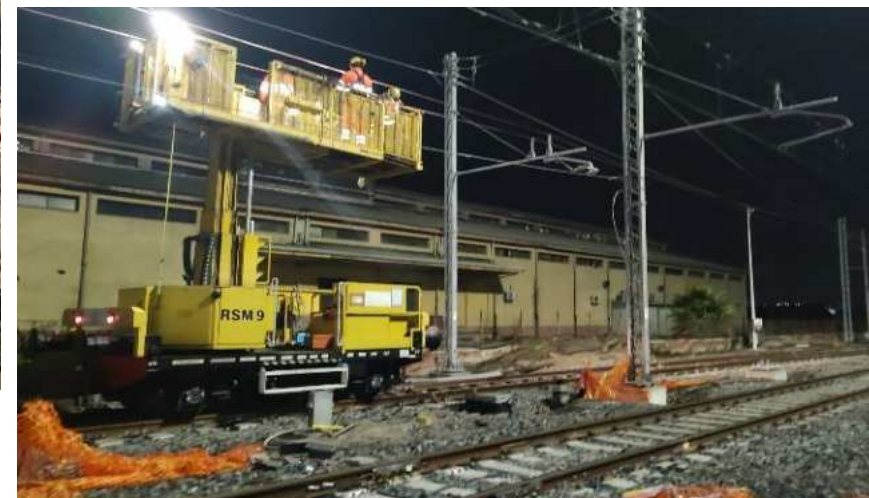
Interventi in ambito stazione di Bicocca eseguiti in 5 fasi Trazione Elettrica
