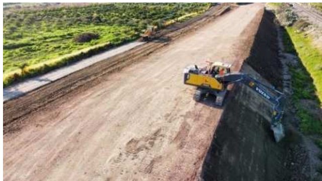
Fase di riprofilatura della scarpata
