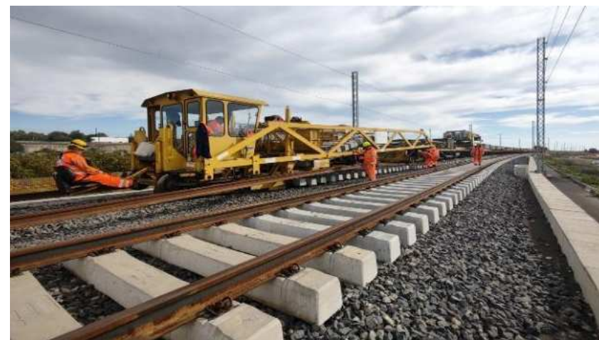
Realizzazione dell'armamento ferroviario con treno speciale per la costruzione del binario
