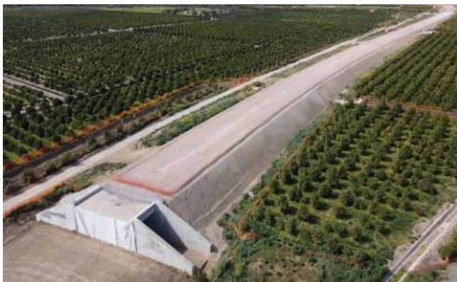
Rilevato ferroviario in terra stabilizzata a calce completo con lo strato di supercompattato
