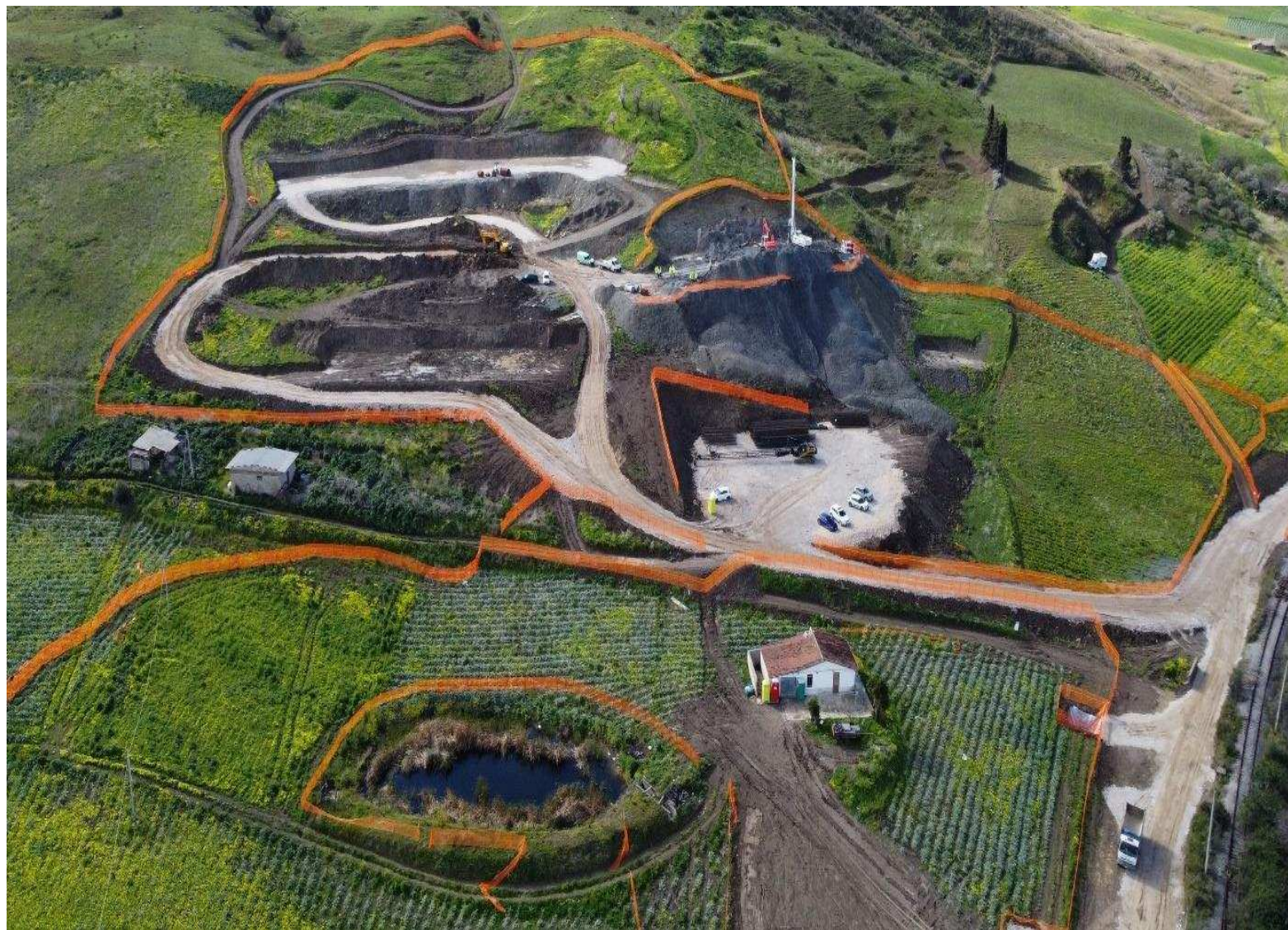
Panoramica imbocco Galleria Alia direzione Catania
