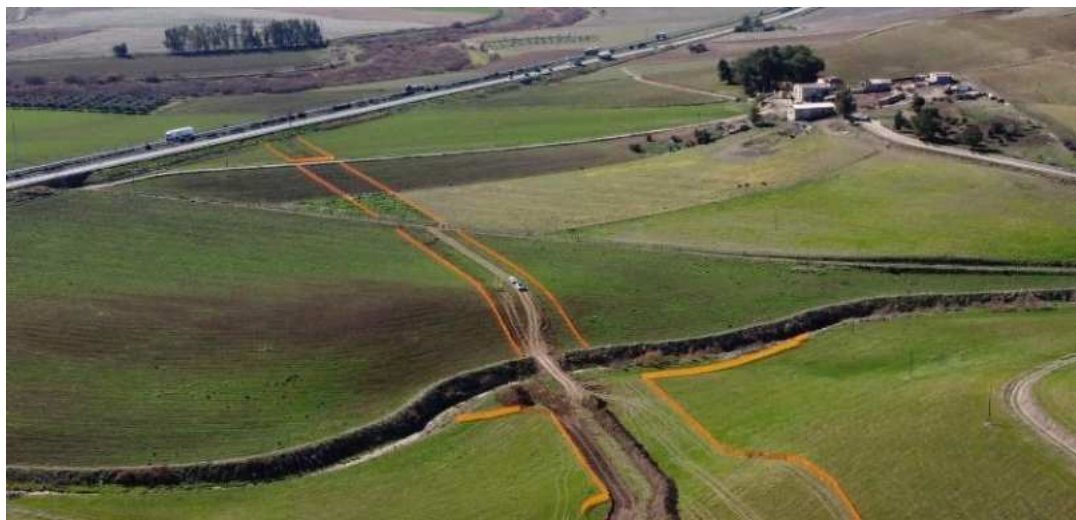
VI12 – Viadotto ferroviario torrente Finaita
