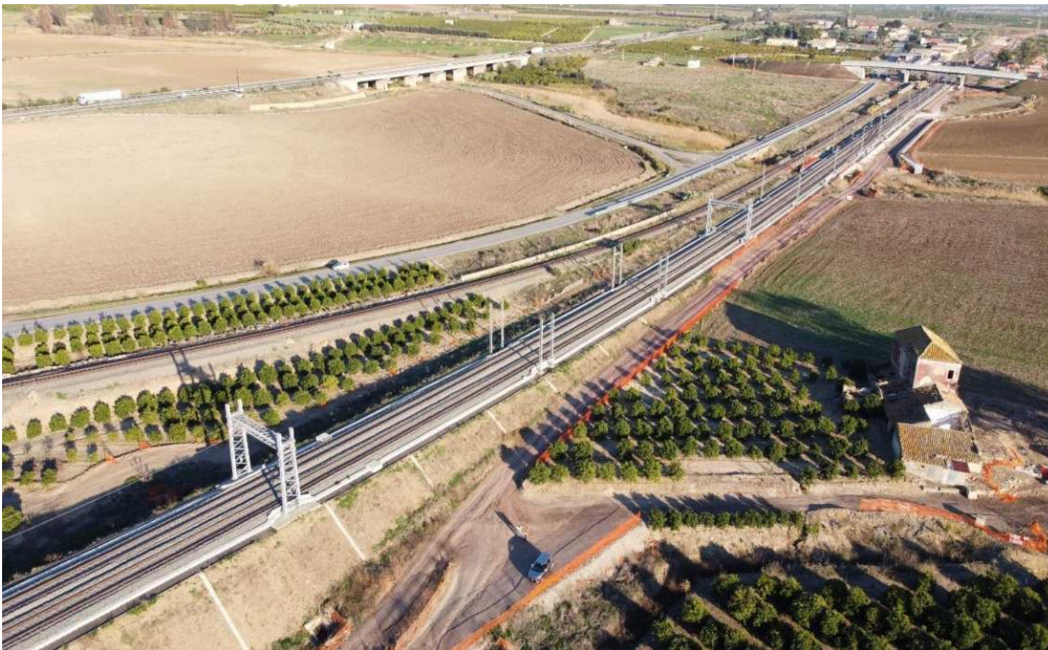
Raddoppio Catenanuova – Sferro in fase di completamento
