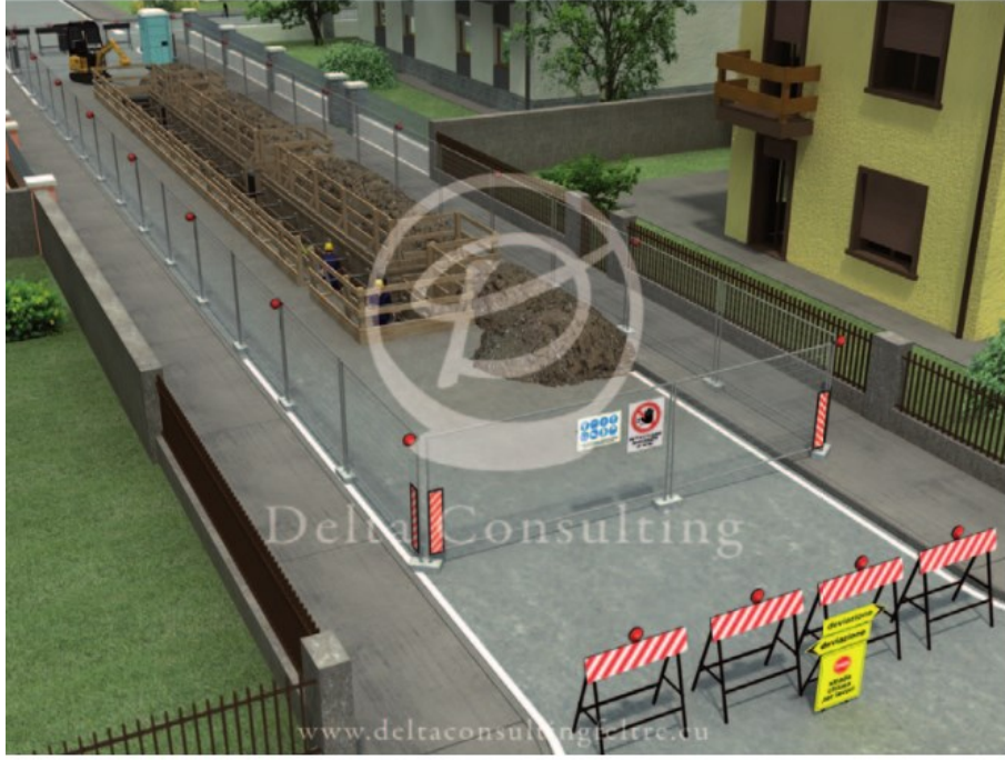
Cantiere fisso per la realizzazione degli scavi
