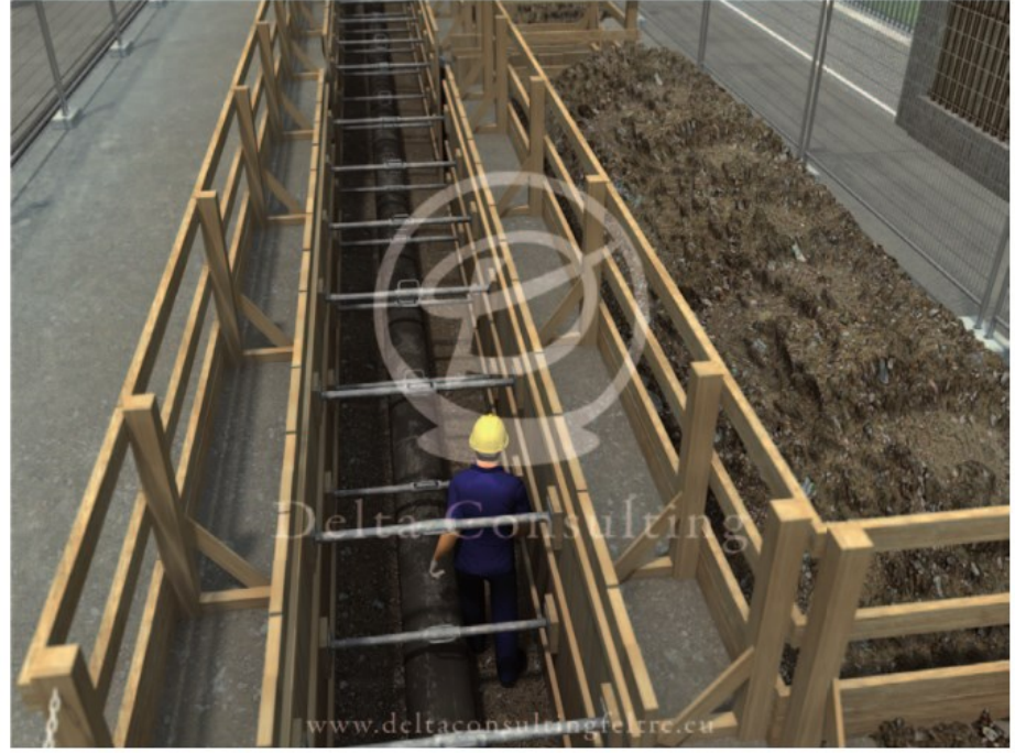
Cantiere fisso per la realizzazione degli scavi
