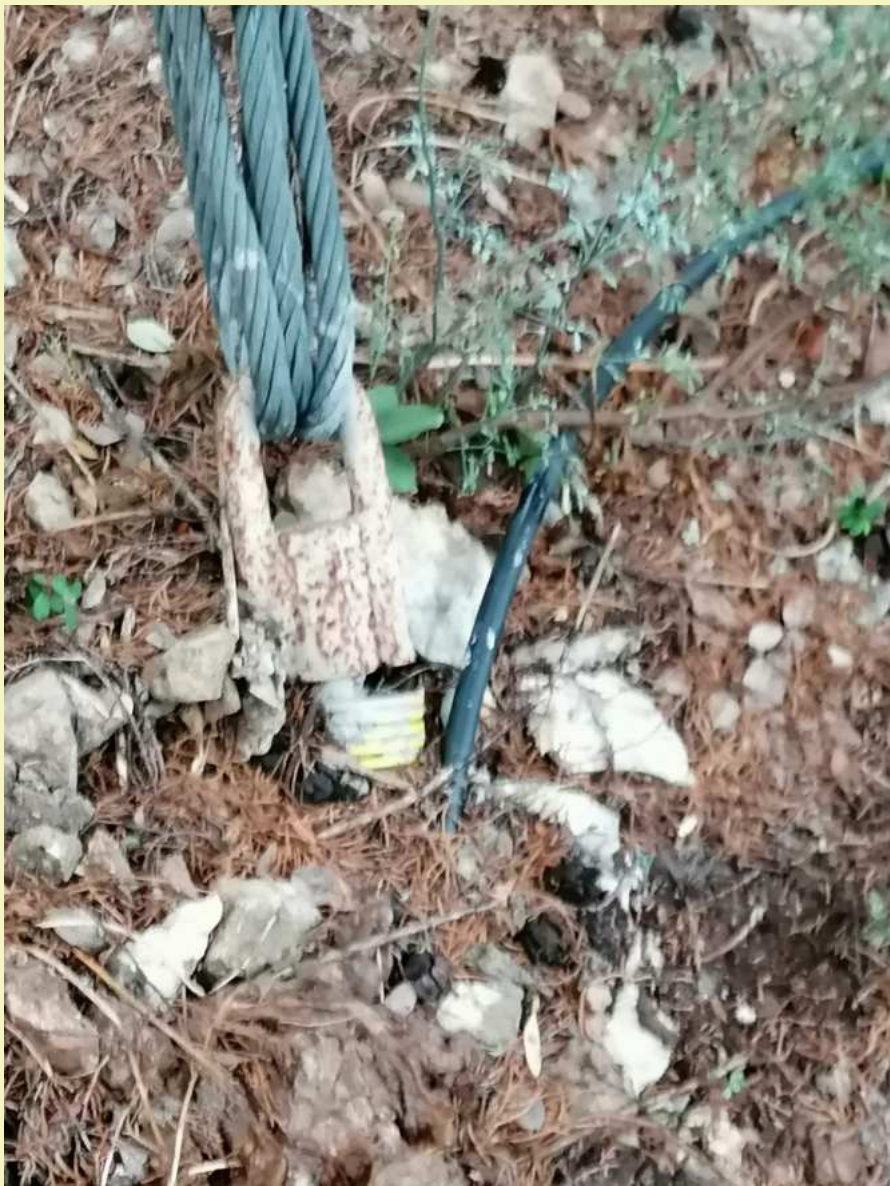
Ancoraggio dei controventi laterali della barriera n°6
