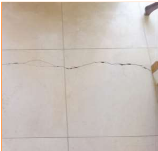
Rottura della piastrella
